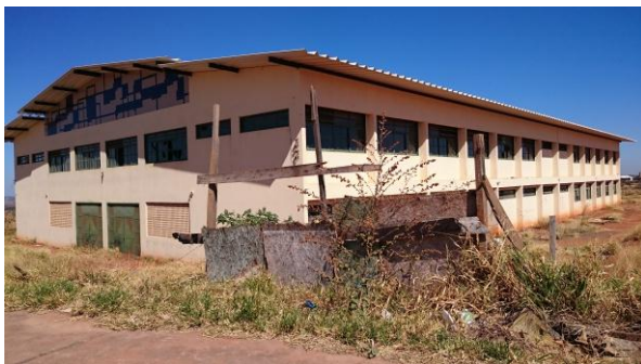
Foto 1 – Obra inacabada da Escola Técnica do Recanto das Emas – DF
