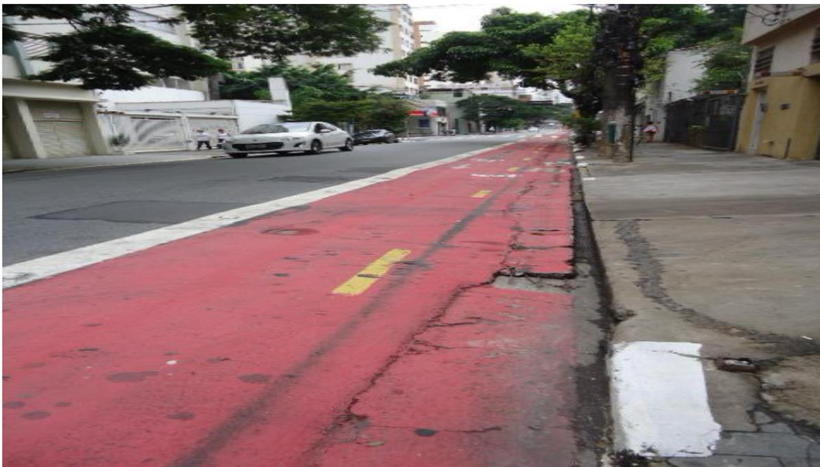
Vista da ciclofaixa da R. Artur de Azevedo, proximidade do no 1.439, com superfície irregular e com faixa lindeira à guia obstruída por rampa de concreto.
