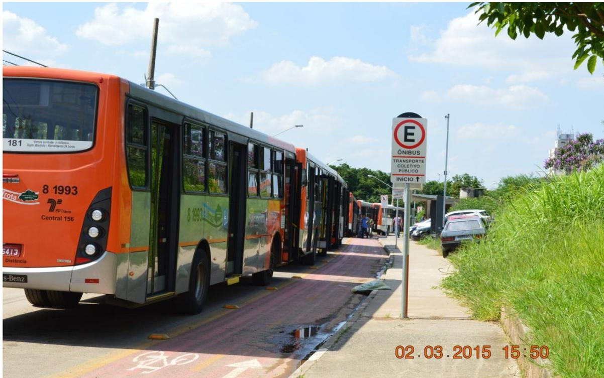
Vista da ciclofaixa/ciclovia da Av. Escola Politécnica, altura do no 5.165, com pintura apagada, com empoçamento de água e ao lado do ponto final de ônibus.
